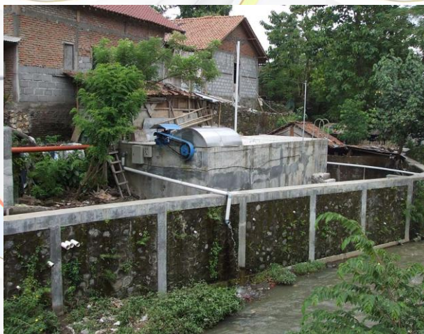
Gambar 8. IPAL Domestik Komunal Karang Waru Melayani 120 KK dengan Teknologi Anaerobik & Aerobik
