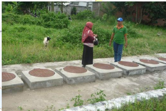
Gambar 10. IPAL Padukuhan Pondok Condong Catur Sebelum Renovasi
